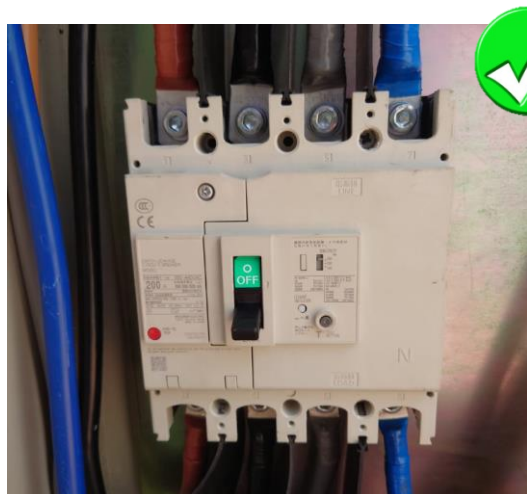
客戶的低壓總開關應有電流式漏電斷路器。
