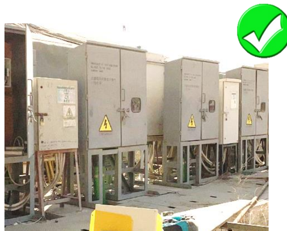
防風雨箱及客戶的低壓總開關箱的位置須安裝在建築工地周邊及面向行人路，防風雨箱正前方須提供不少於 900 毫米的工作空間。
