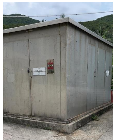
由港燈提供的預製組件式變壓器配電箱
