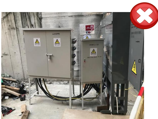
客戶的低壓總開關箱安裝在建築工地範圍內，及面向工地而非行人路。
