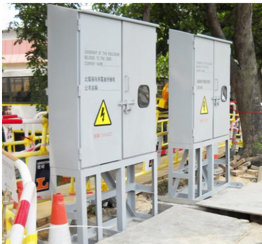
港燈提供的防風雨箱以安裝供電熔斷器及電表
